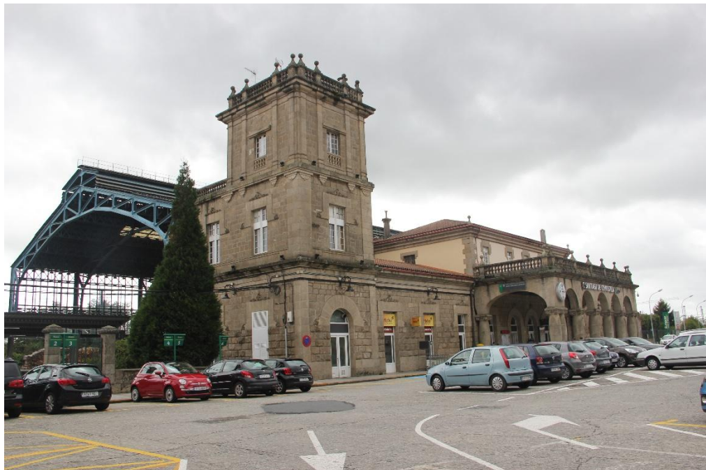
Estación de Santiago de Compostela, uno de los nodos clave del Corredor Atlántico.
