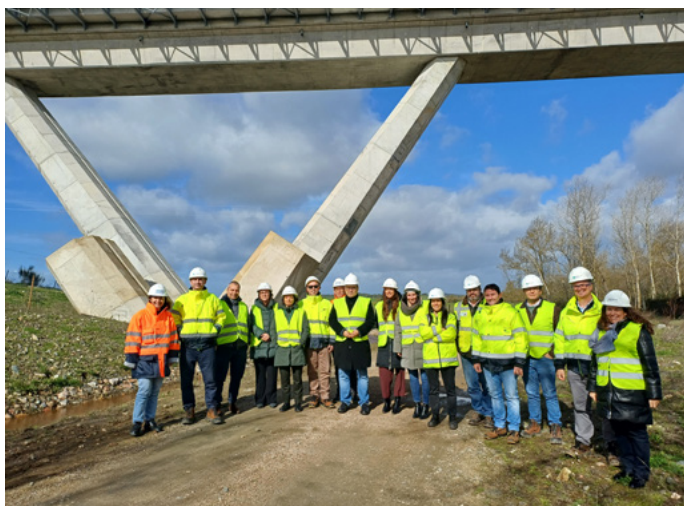
Visita, con el administrador de infraestructuras de Portugal, de las obras de la línea Évora-Elvas.
