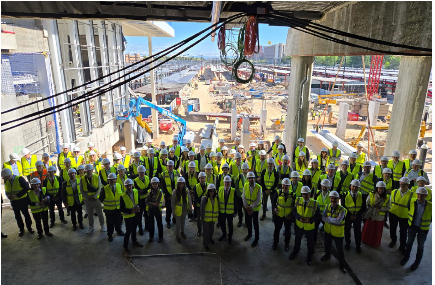
Representantes de la red TEN-T visitaron, en el marco de foro de alta velocidad celebrado en Madrid, las obras de la estación Madrid Chamartin Clara Campoamor.
