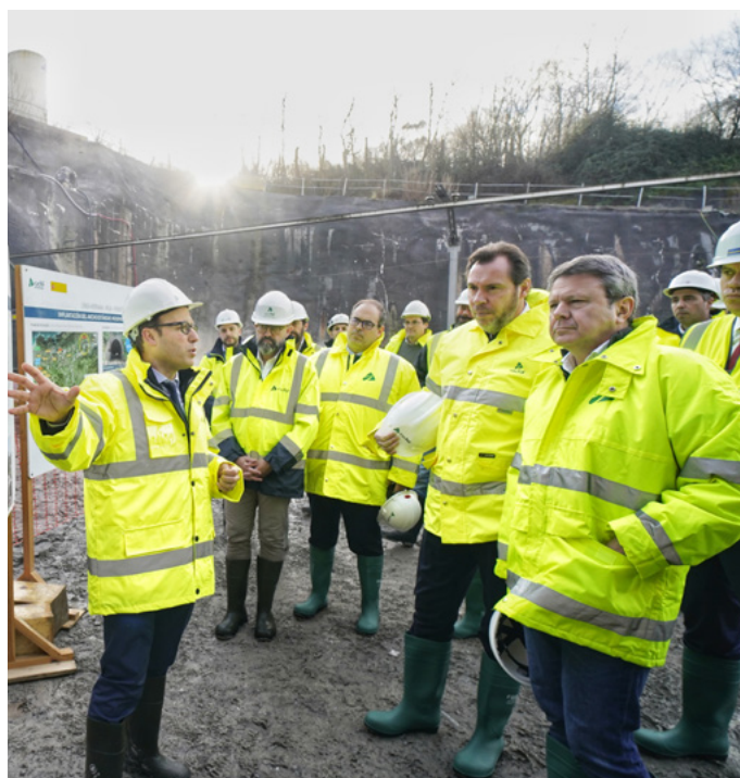
Visita a las obras de la Y Vasca junto al ministro de Transportes y Movilidad Sostenible.
